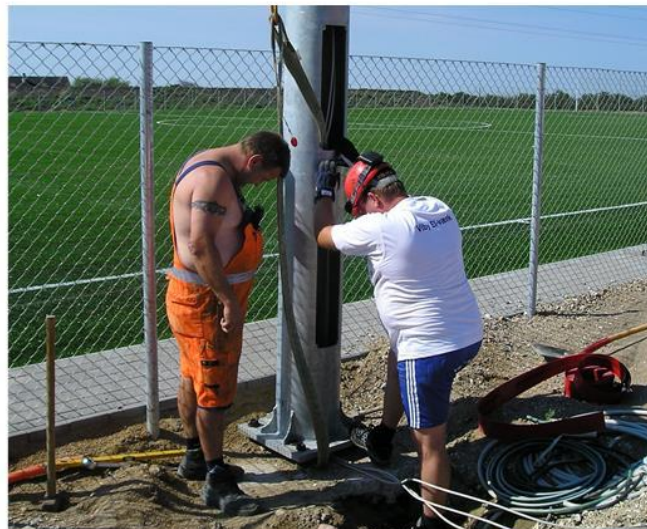
8. Masten på plads - undgå at beskadige boltene's gevind.
